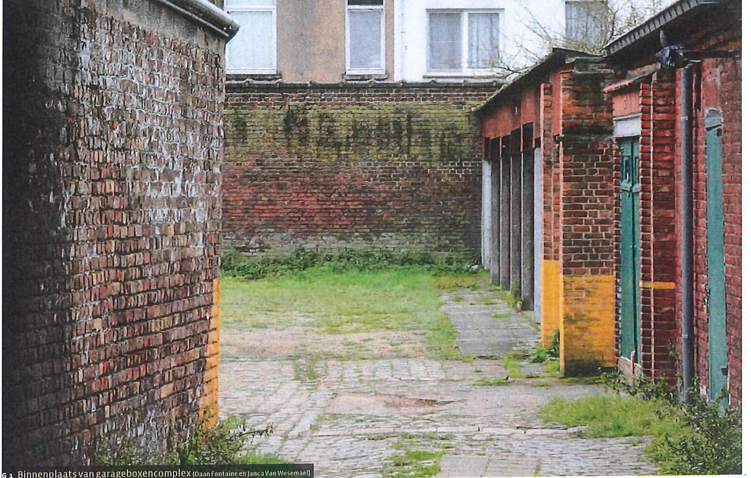
6.1 Binnenplaats van garageboxencomplex (Daan Fontaine en Janca Van Wesemael)
