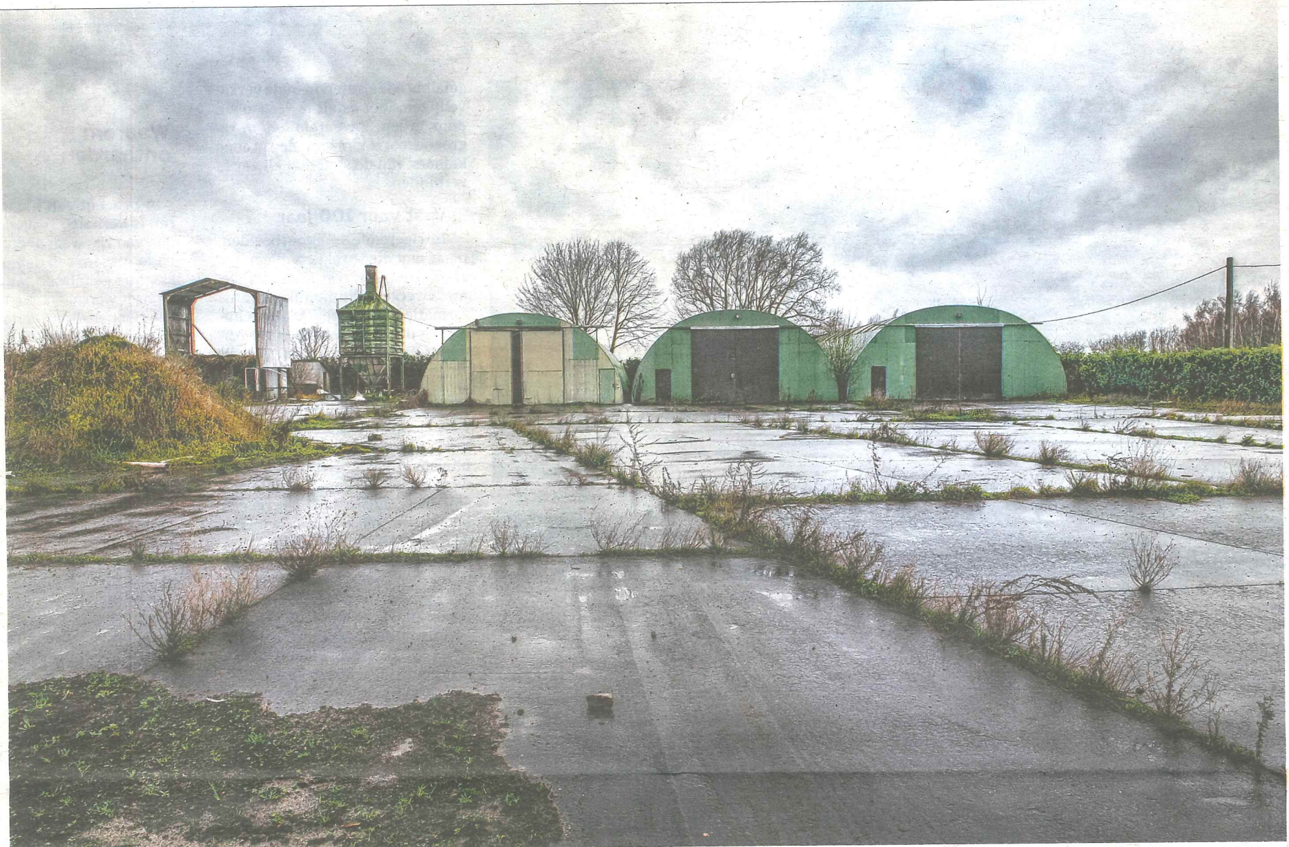
Drie verlaten loodsen op een verhard terrein in Dentergem, tussen akkers en velden. Een ideale locatie om vrachtwagens af en aan te laten rijden is dit niet. ©
