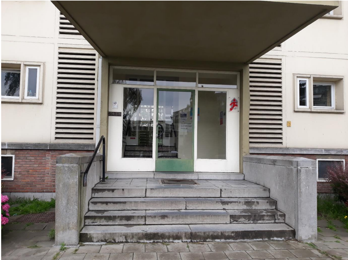
Figuur 4 Ingang van een sociaal appartementsgebouw in Gent
